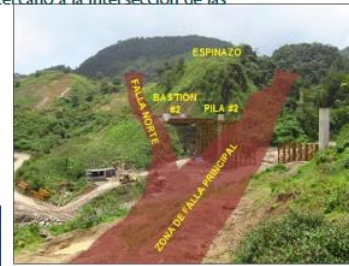
Fotografía 5. Panorámica que muestra la proyección de las fallas respecto al morro o espinazo
