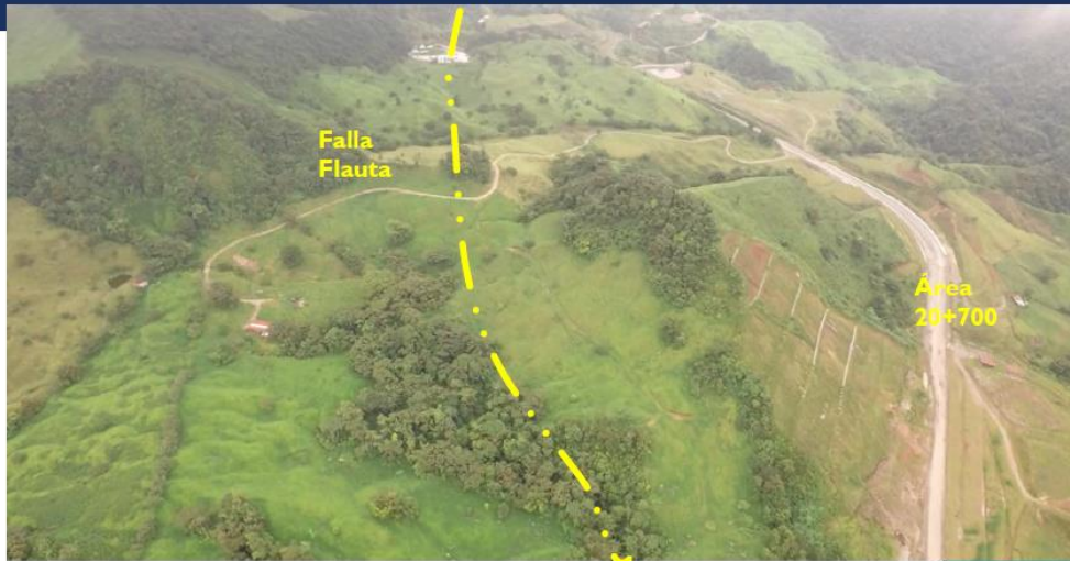
Imagen aérea previa al deslizamiento
