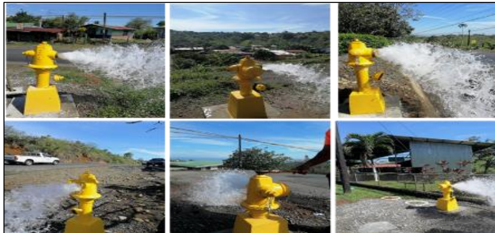
Ilustración 17. Hidrantes instalados
