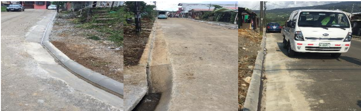
Ilustración 2 Mantenimiento aceras en Gamonales
