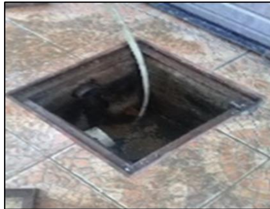
Ilustración 23. Mantenimiento cajas de registro
