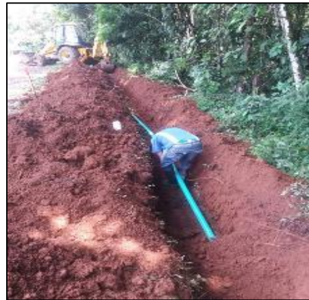
Ilustración 20. Instalación de red de distribución y conducción
