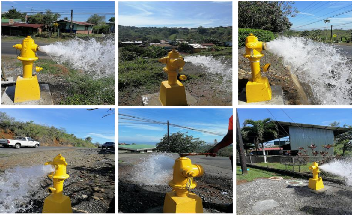
Ilustración 6 Instalación de hidrantes Puente Casa y San Pablo
