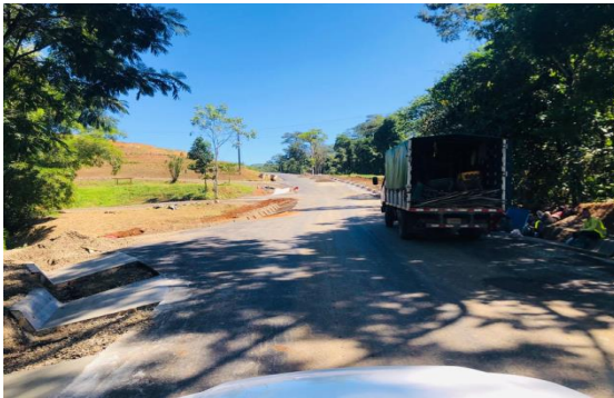
Ilustración 18 Colocación de cuneta y asfalto
