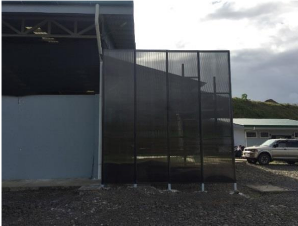
Ilustración 21 Obras complementarias Feria del Agricultor
