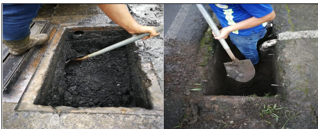
Ilustración 2. Limpieza de cajas de registro
