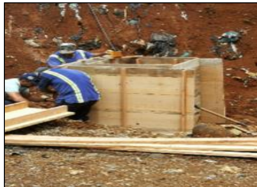
Ilustración 9. Construcción de cajas de registro
