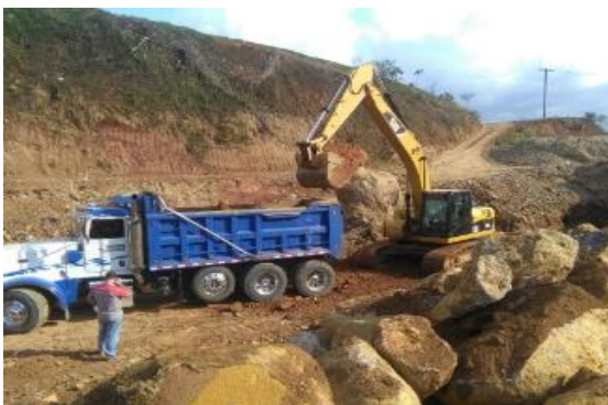
Ilustración 19 Movimiento de tierra Relleno Sanitario
