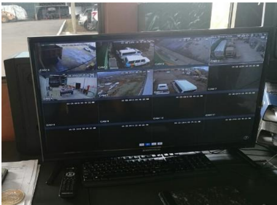
Ilustración 9 Cámaras de vigilancia
