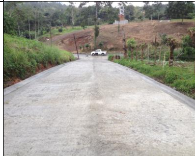
Losa de concreto Santo Domingo, cuadrantes de Monterrey, camino 2-10-164.
