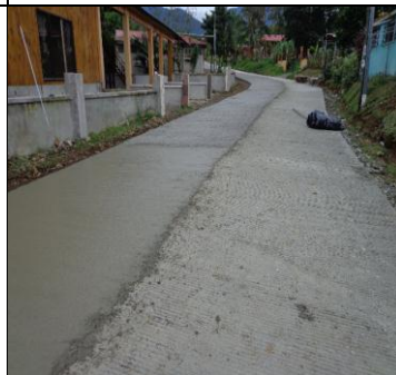
Losa de concreto Calle Morales de A. Z, camino 2-10-138.
