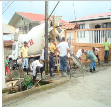
Losa de concreto San Miguel de C. Q., camino, CAMINO2-10-153.
