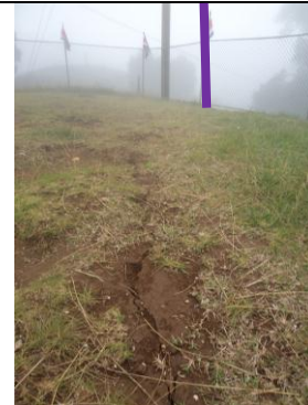
Deslizamiento y grieta en el terreno de área de juego de la Escuela
