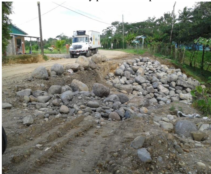
Se reduce el riesgo de mayor deslizamiento, brindando un paso más seguro a los usuarios de la vía
