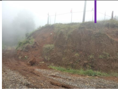
Deslizamiento y grieta en el terreno de área de juego de la Escuela
