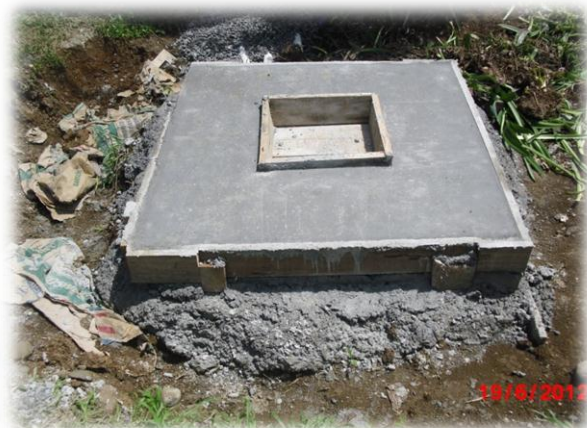
Evacuación pluvial mediante Colocación de Tubos de Concreto y Construcción de Cordón y Caño y CR 50m 3 f'210kg/cm 2 en camino 2-10-153, Costado Oeste del Hotel Plaza, Ciudad Quesada.
