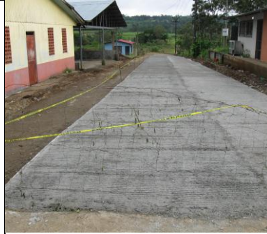
Losa de concreto Santa Rosa de la Palmera, Camino 2-10-753.
