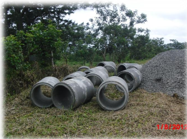
Evacuación pluvial mediante Colocación de Tubos de Concreto y Construcción de Cordón y Caño y CR 50m 3 f'210kg/cm 2 en camino 2-10-153, Costado Oeste del Hotel Plaza, Ciudad Quesada.
