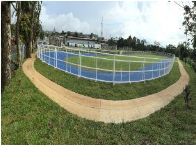
Proceso constructivo estructura de la pista (1412m 2 )
