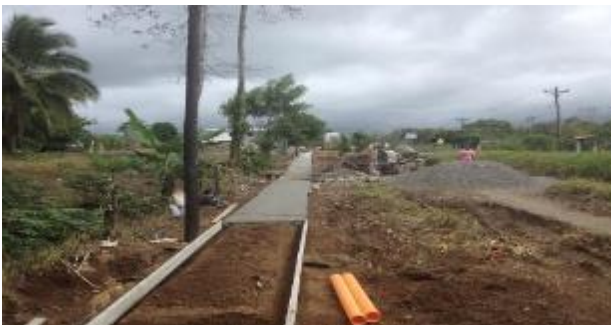
Construcción Acera Los Chiles de Aguas Zarcas
