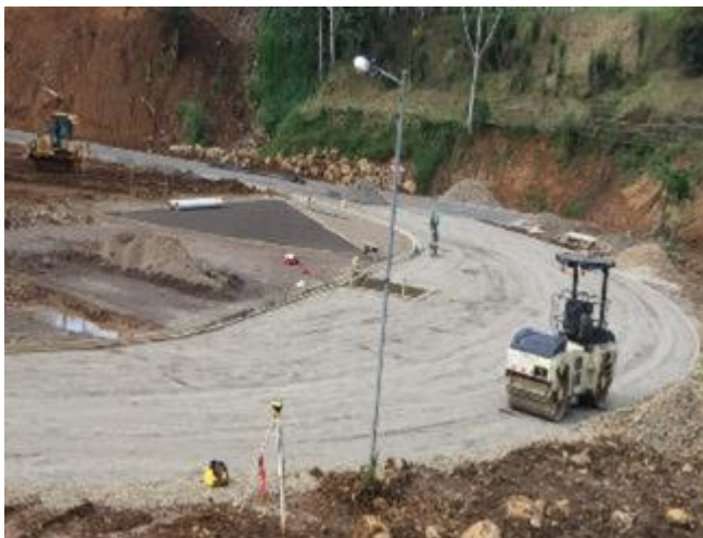
Estructura de pavimento (5556 m 2 )
