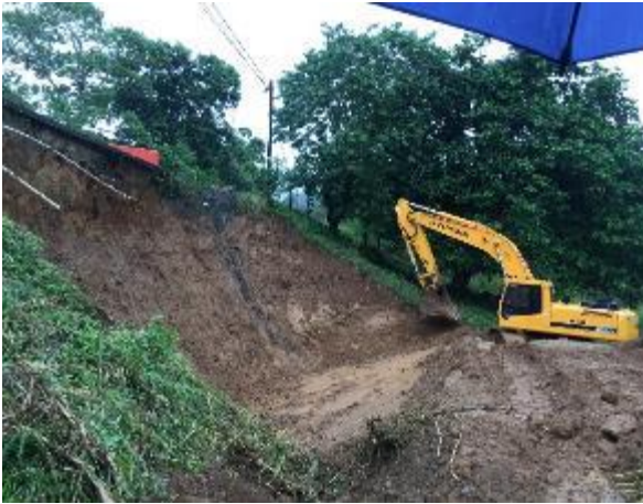
Limpieza y recuperación del tramo de camino 2-10-002. C, Q.
