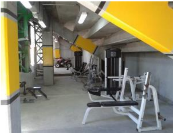
Aprovechamiento de espacio bajo gradería y reconstrucción acceso de los túneles, muro frontal de cerramiento (70m)
