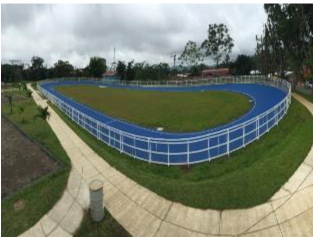
Revestimiento de la superficie con emulsión acrílica antideslizante con color de acabado y Demarcación de bordes(1412m 2 )
