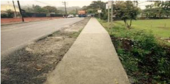
Construcción Acera San Martin de Venecia
