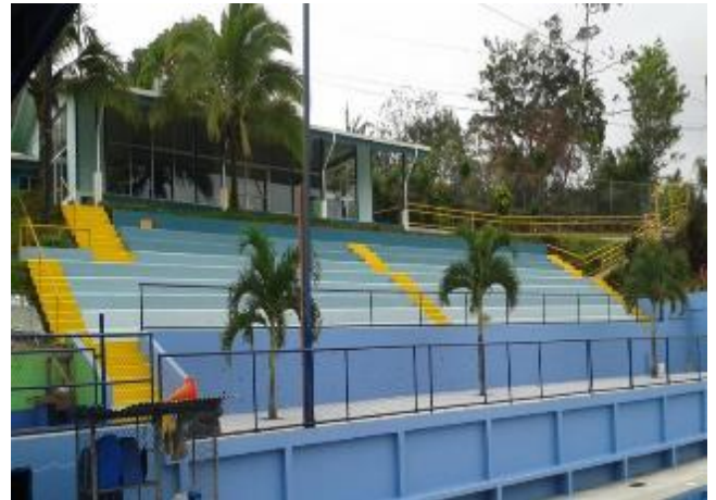
Construcción de gradería de concreto (96m 2 - 186
