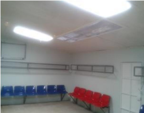
Pintura, iluminación natural e instalación eléctrica módulo de vestidores
