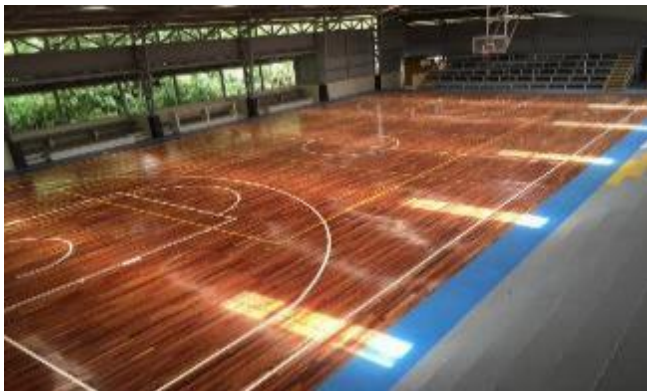
Proceso Reconstrucción total del piso de madera
