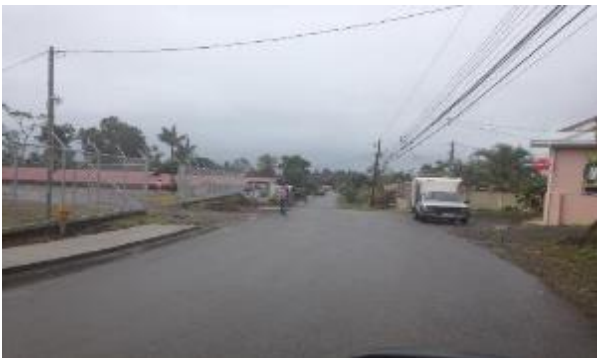
Construcción Acera San Martin de Venecia
