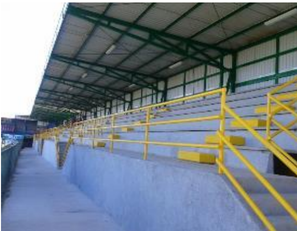
Sistema de iluminación de la gradería con balastro de emergencia incorporado
