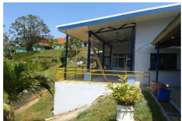
Demolición y construcción de nuevo edificio sector norte (400m 2 aproximadamente.
