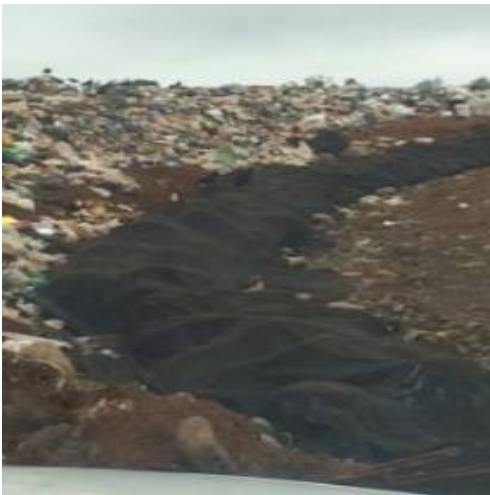
Construcción de drenajes
