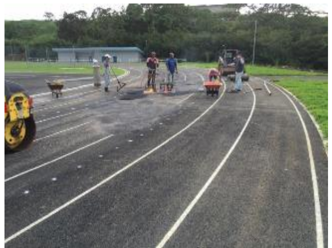
Constr. Carpeta Asfáltica (5556 m 2 ) y demarcación
