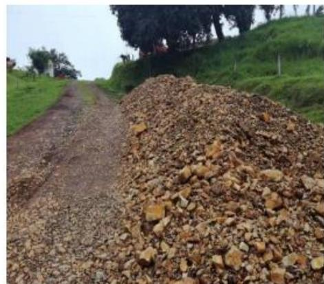
Paso habilitado con gran cantidad de material granular estoqueado en los accesos que se utilizara para relleno de los espacios necesarios una vez se hayan construido los cabezales de concreto.
