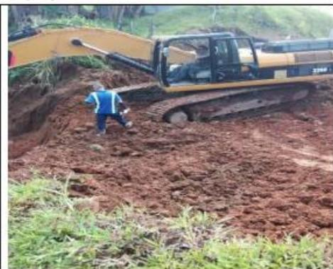
Proceso de colocación del primer material granular, para lo cual se presentaron inconvenientes en la operación del equipo por contar con un brazo corto.
