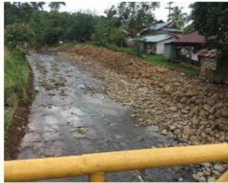
Limpieza de cauce y apilamiento de material granular para protección de puente peatonal y paso sobre cauce camino 2-10-885 Poblado de Quebrada Azul.
