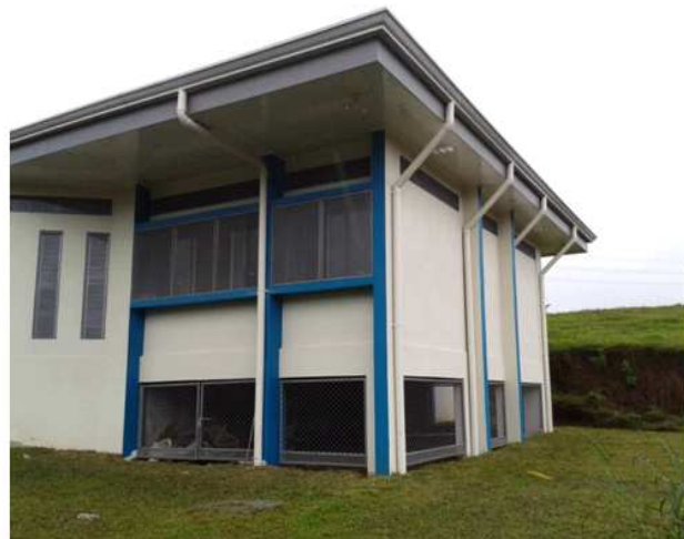
VISTA DESDE COSTADO NOROESTE
