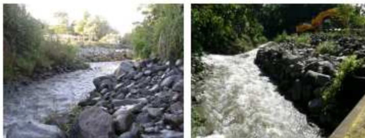
Protección de márgenes y canalización del río Platanar, en beneficio y protección de la infraestructura vial cantonal camino 2-10-002.
