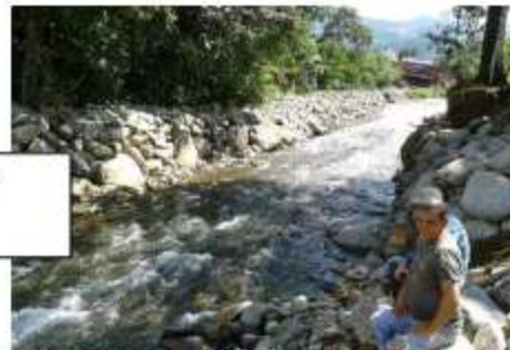
Diques construidos para protección de ambas márgenes del río Platanar. Inmediato a camino 2-10-962 y puente en construcción.
