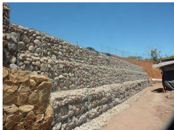
Muro de contención
