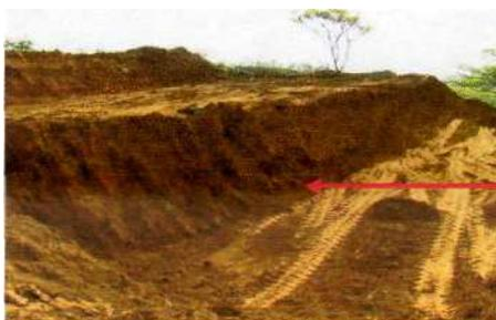
Cortes del terreno para conformar lotes, terrazas de 1.5m y 2.0m de altura.
