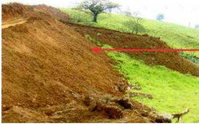
Taludes de relleno para la conformación de lotes, se observa que no se han realizado trabajos para su estabilización o contención.
