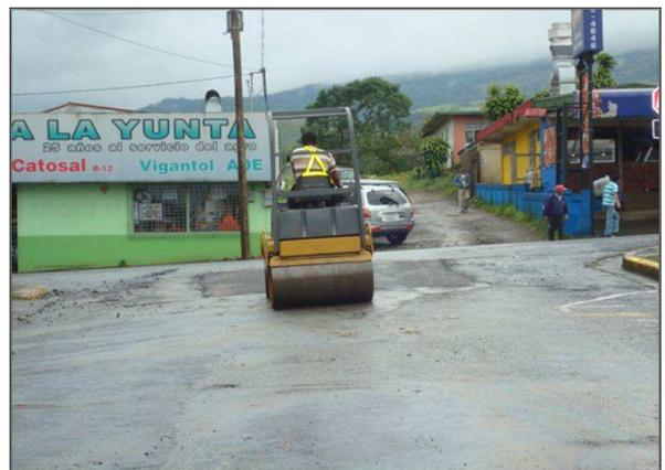
2. Mantenimiento rutinario de vías en asfalto en el Cantón de San Carlos prioridad de la JVC, Bacheo 700 ton mezcla asfáltica en caliente.
