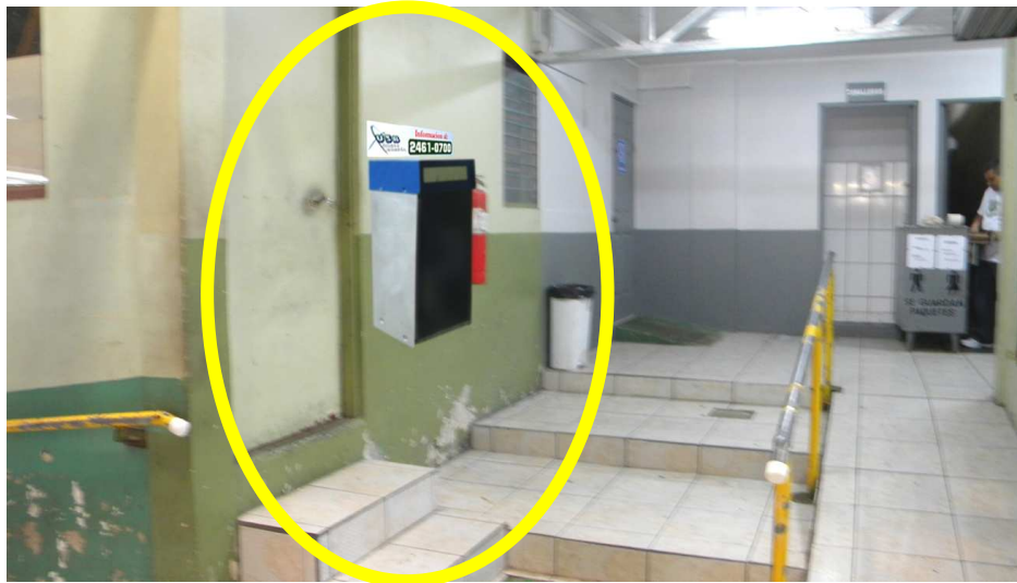
Costado Sur, en el pasillo de los baños
