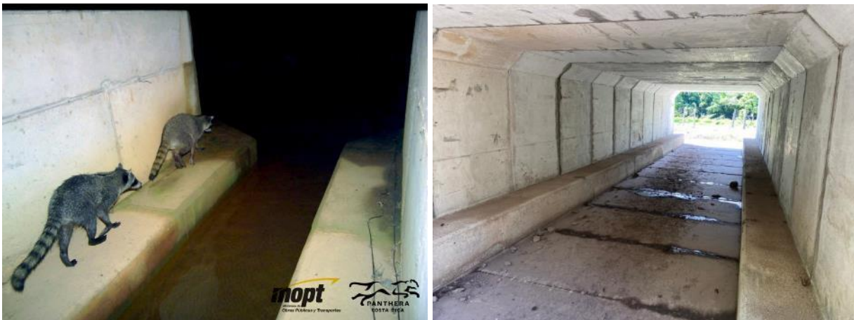
Figura 111. Ejemplo de drenaje adaptado para el paso de fauna. Se observan las pasarelas a ambos lados del curso de agua. Izquierda: Chilamate- Vuelta Kooper (ruta 4), Derecha: Playa Naranjo-Paquera (ruta 160).
