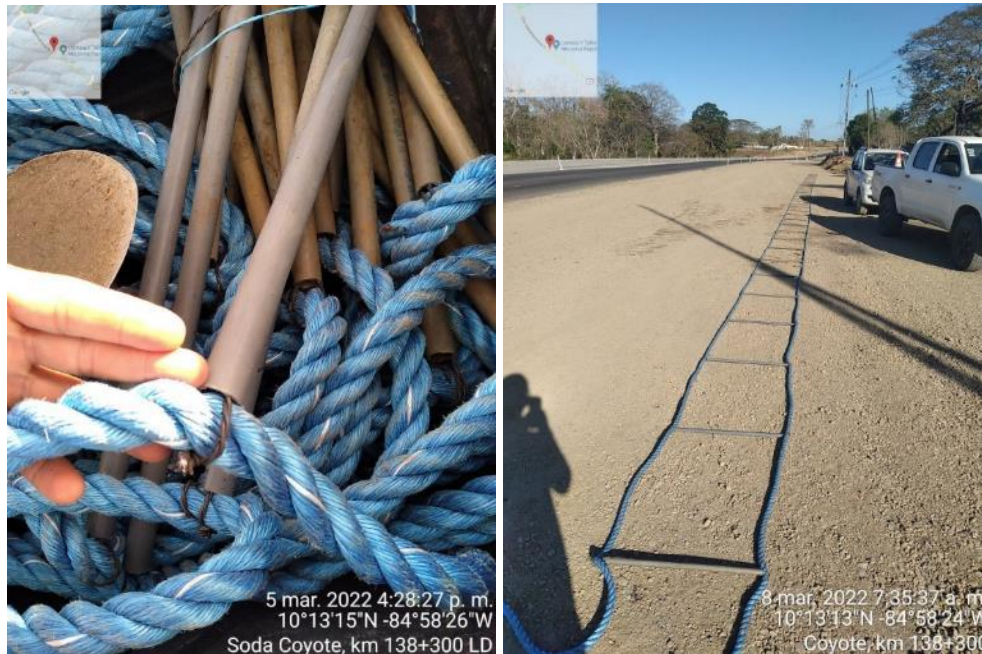
Figura 112. Ejemplo de materiales y construcción de pasos aéreos con material base mecate de polietileno y uniones de tubo PVC, carretera ruta 1 sección Cañas-Limalom.
