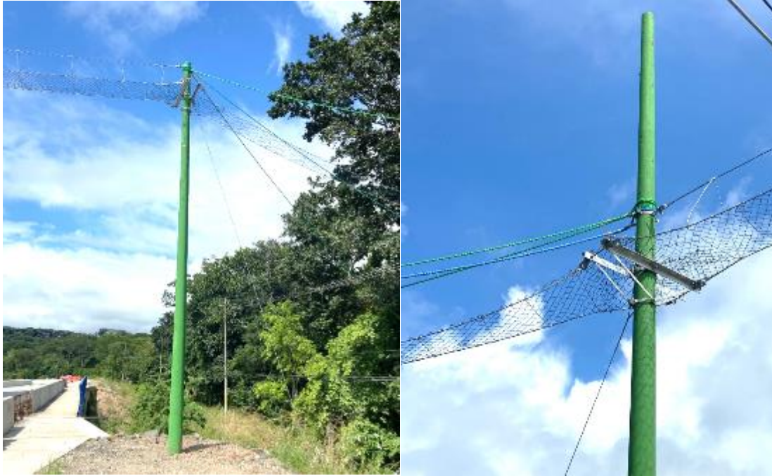
Figura 117. Ejemplo de pasos aéreos, se observan los postes con soporte, conexión hacia los árboles y anclaje de 3 tiroleras, carretera ruta 1 sección Cañas-Limonal.
