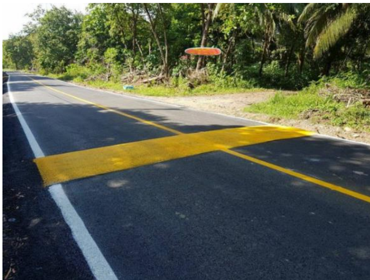
Figura 124. Ejemplo de reductor de velocidad instalado en Vías Públicas Terrestres.
