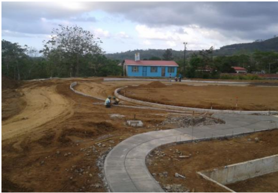
Ilustración 26. Vista panorámica de avance en la estructura de pavimento, confinada por los bordillos y cuneta especial en concreto.
