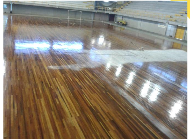
Ilustración 39, 40 y 41. Proceso aplicación producto poliuretano en capas y fijado grano fino entre cada capa.
