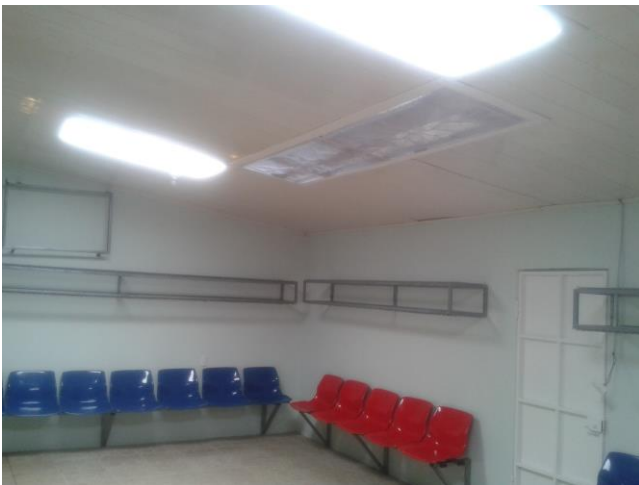
Ilustración 31 y 32. Interior de los vestidores, pintura, instalación de block ornamental para ventilación y de láminas acrílicas y difusoras (con malla de acero para seguridad) generando iluminación natural e independencia total en uso de salidas luminarias durante horas luz.
