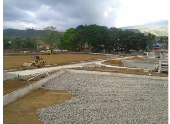
Ilustración 26. Vista panorámica de avance en la estructura de pavimento, confinada por los bordillos y cuneta especial en concreto.
