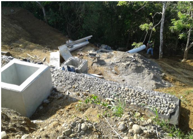
Ilustración 24 y 25. Construcción de Cajas de Registro y tuberías de evacuación pluvial hasta el río. Así como construcción del sistema de evacuación pluvial interno de la pista de patinaje.
