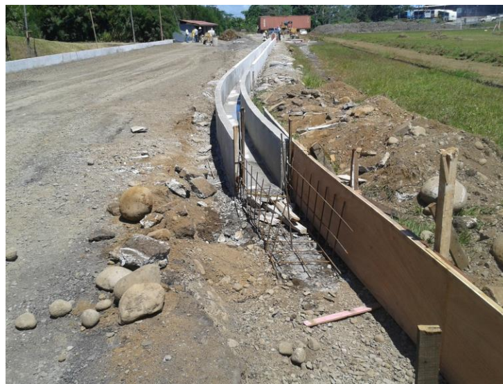
Ilustración 1 y 2 . Proceso constructivo de la cuneta interna de la pista costado Oeste, tanto en la recta como inicio de la curva. conformando una plataforma compactada para brindar la elevacion requerida.
