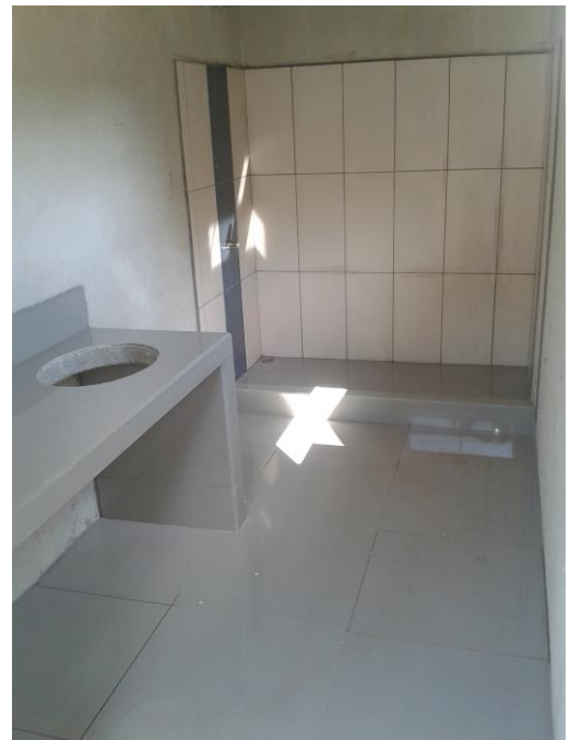
Ilustración 42, 43, 44 y 45. Proceso cerramientos con malla ciclón, pintura de estructuras metálicas, así como enchapes y pisos en porcelanatos modulo servicios sanitarios-vestidores nuevos.
