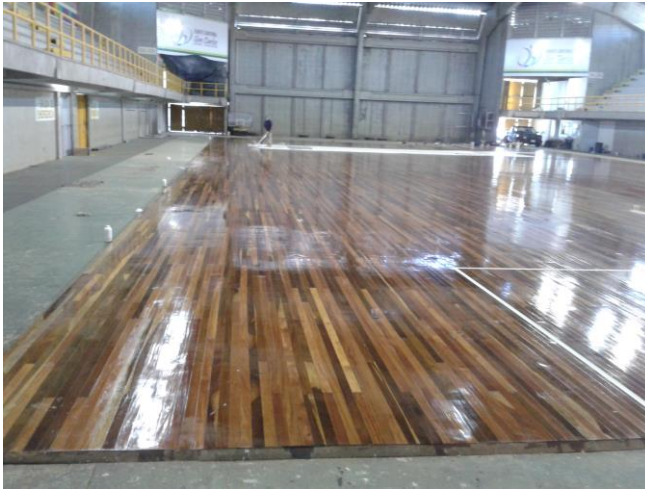
Ilustración 39, 40 y 41. Proceso aplicación producto poliuretano en capas y fijado grano fino entre cada capa.
