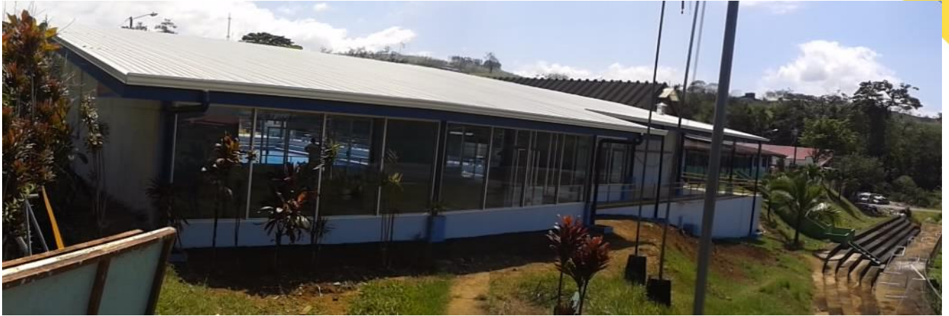
Ilustración 23. Vista panorámica del edificio.
