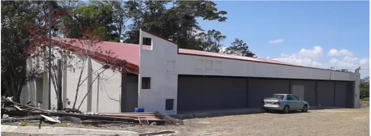
Ilustración 19 y 20. Proceso de pintura en exteriores.
