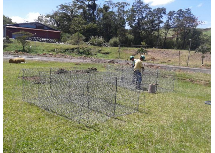
Ilustración 7 y 8. Armado de canastas para muro de gavión.
