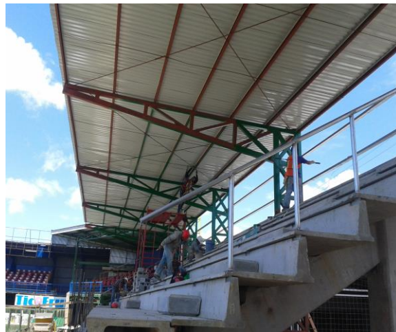
Ilustración 33 y 34. Estructura de Gradería prefabricada totalmente instalada en sitio, así como acceso a la misma.
