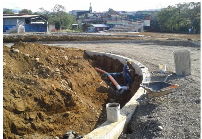
Ilustración 24 y 25. Construcción de Cajas de Registro y tuberías de evacuación pluvial hasta el río. Así como construcción del sistema de evacuación pluvial interno de la pista de patinaje.
