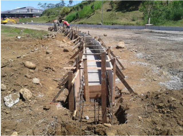
Ilustración 3 y 4. Proceso constructivo de la cuneta interna inicio de la curva costado Este.
