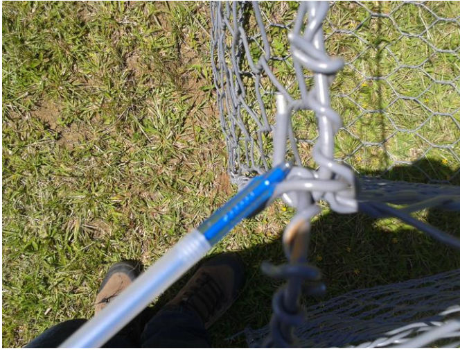
Ilustración 7 y 8. Armado de canastas para muro de gavión.
