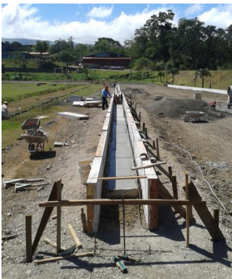
Ilustración 1 y 2 . Proceso constructivo de la cuneta interna de la pista costado Oeste, tanto en la recta como inicio de la curva. conformando una plataforma compactada para brindar la elevacion requerida.
