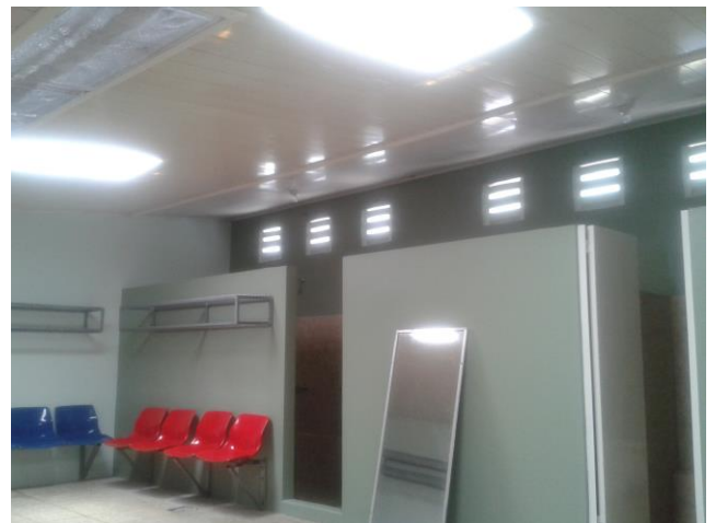
Ilustración 31 y 32. Interior de los vestidores, pintura, instalación de block ornamental para ventilación y de láminas acrílicas y difusoras (con malla de acero para seguridad) generando iluminación natural e independencia total en uso de salidas luminarias durante horas luz.
