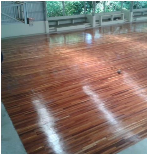
Ilustración 17 y 18. Proceso aplicación producto poliuretano en capas.
