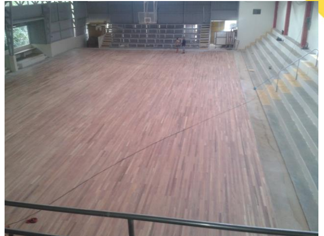
Ilustración 15 y 16. Proceso de fraguado del piso de madera, lijado de fragua y remoción de polvo.
