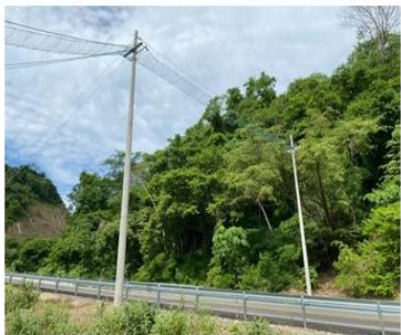
Paso aéreo tipo triangular con base de malla
