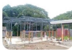
Construcción obra nueva
