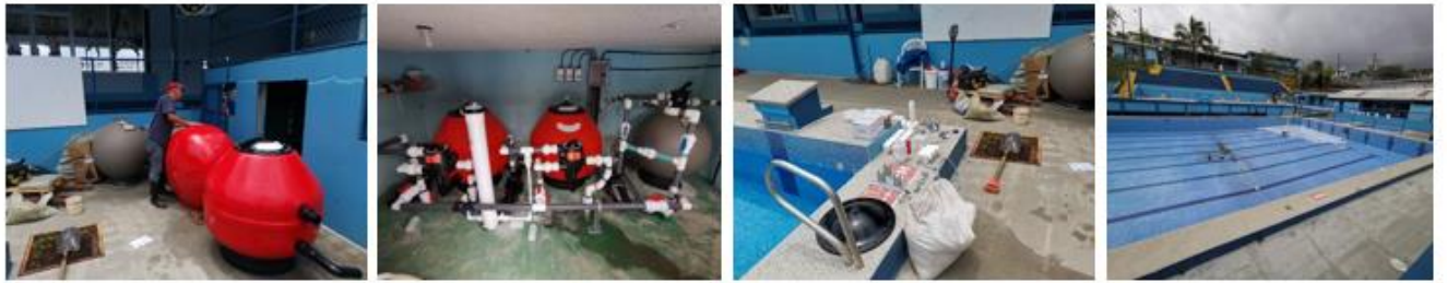
1 Cambio de sistema de filtrado y mantenimiento total de piscina de Ciudad Deportiva
