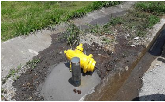
6 Ilustración 72 Instalación de hidrantes
