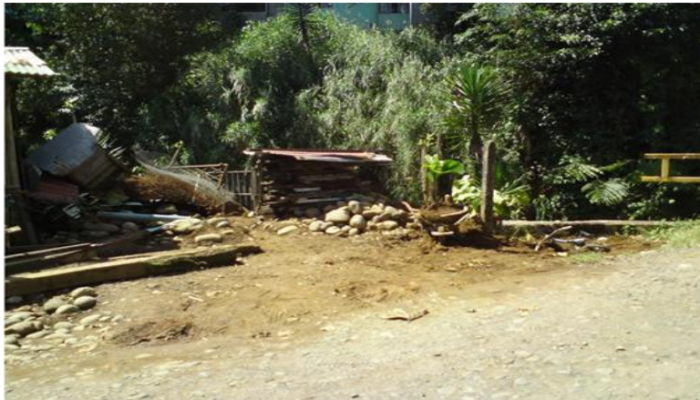
20 Construcciones cercanas al puente sobre la Quebrada San Pedro, del Barrio Cristo Rey de Ciudad Quesada,
