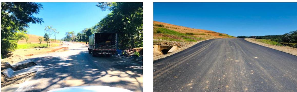
30       *Ilustración 18 Colocación de cuneta y asfalto*
