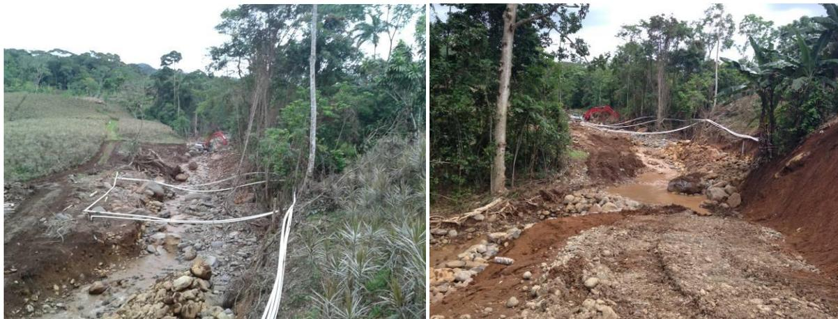
Trabajos aguas arriba y abajo del paso de tuberías de agua potable, en donde se realizó limpieza de cauce y confirmación de material hacia ambos márgenes
