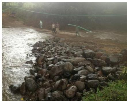
Reconstrucción de acceso a la estructura de paso tipo vado.
