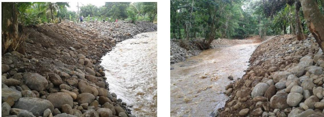
Conformación de dique utilizando el propio material existente en el cauce río La Tigra, siendo este un sitio donde ocurrió desbordamiento hasta alcanzar el camino.
