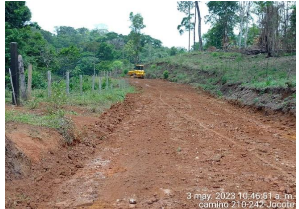
Limpieza y apertura del camino 2-10-242
