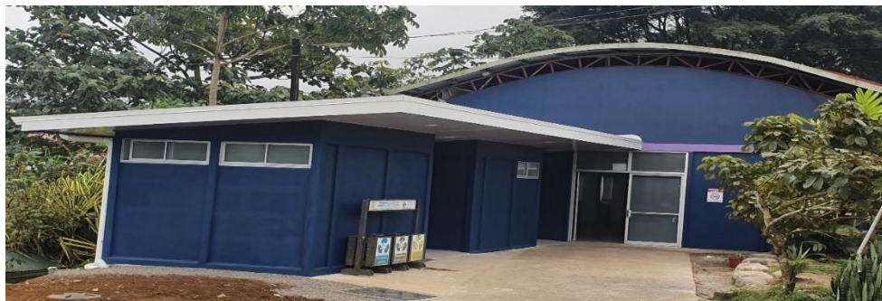
Construcción de baterías en Desarrollo Social
