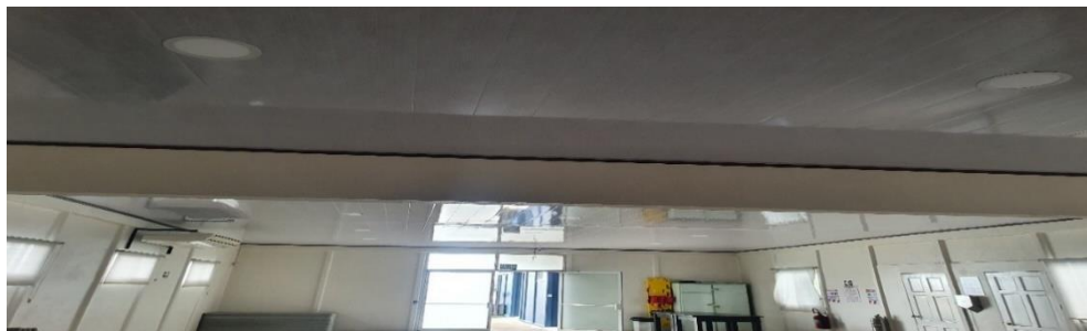
Cambio tablilla de cielorraso
