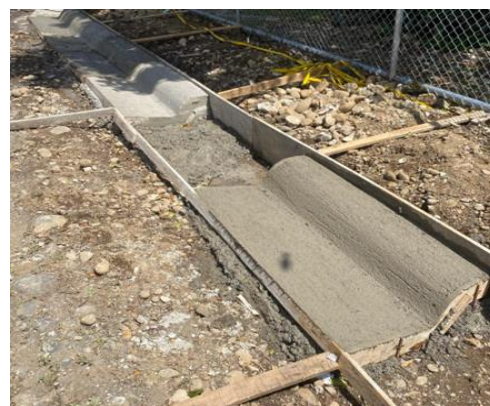
Construcción de aceras, La Leyla
