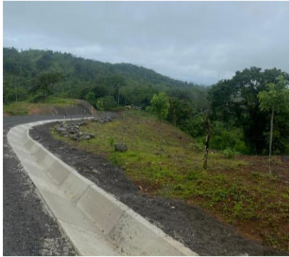
Evacuación Pluvial, Montelimar, Monterrey
