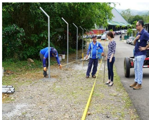
Instalación de cercado detrás de la Casa Cural
