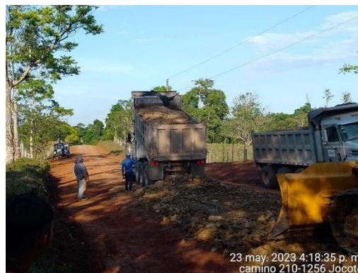
Mejoramiento de todos los sistemas de evacuación pluvial
