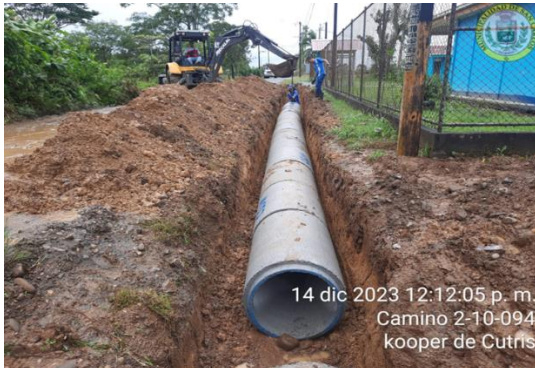
Colocación de alcantarillado Kopper de Cutris Fuente: Comisión Municipal de Emergencias
