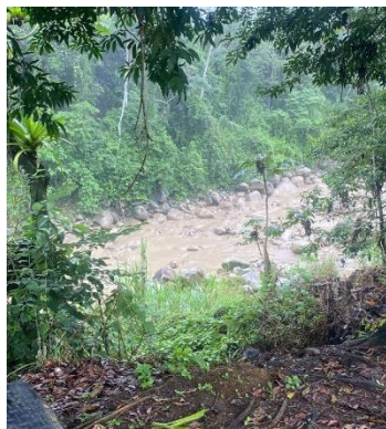
Inspección puente Aguas Zarcas
