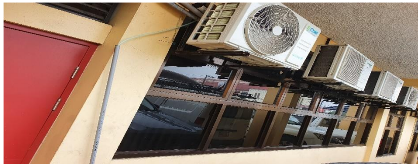
Cambio de Ventanas, Marcos Exteriores
