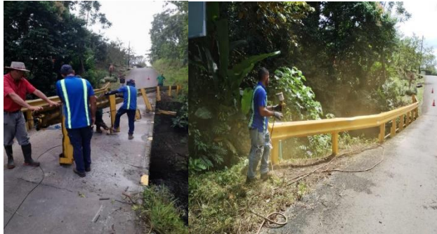
Mantenimiento de Puente, Alto El Palomo, La Palmera.
