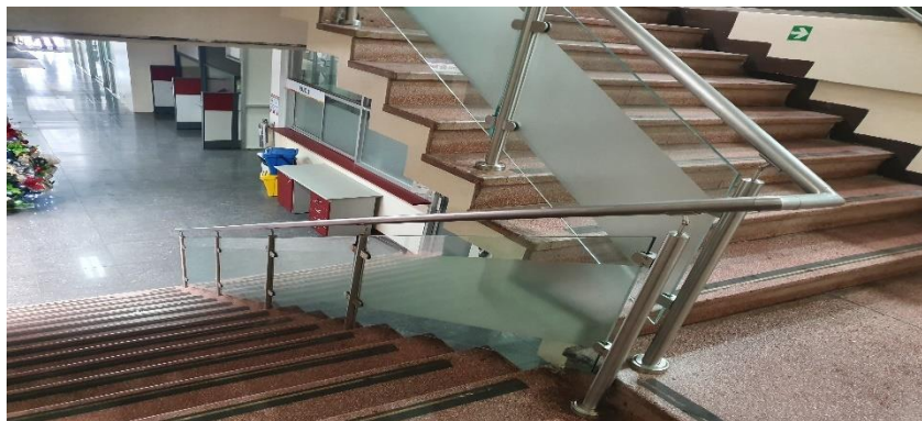
Colocación de baranda
