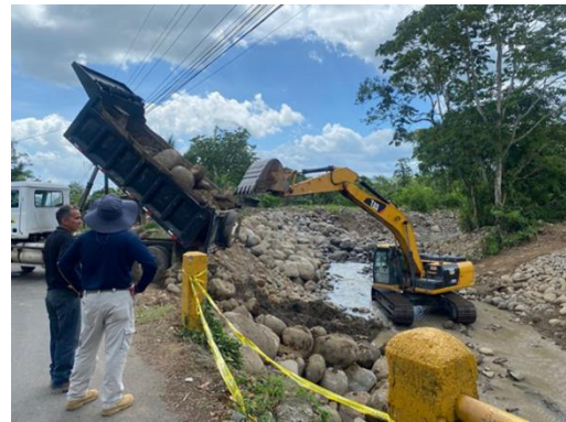
Construcción de enrocados, Los Lotes de Aguas Zarcas Fuente: Comisión Municipal de Emergencias
