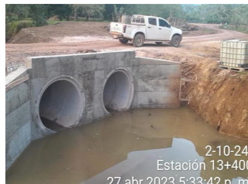
Evacuación Pluvial, Chorreras, Cutris
