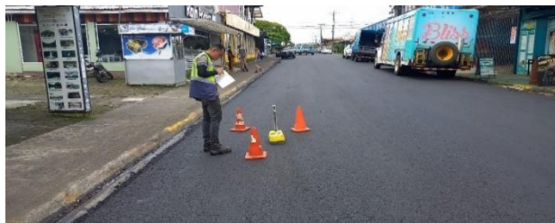
Bacheo en Asfalto, Fortuna
