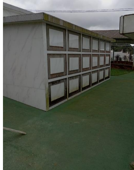
Construcción de nichos
