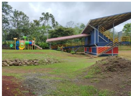
Mantenimiento Infraestructura, La Caporal A.Z Fuente: Municipalidad de San Carlos
