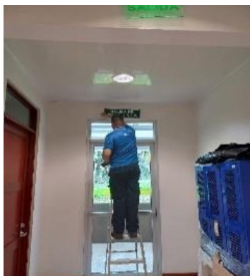
Colocación de rotulación
