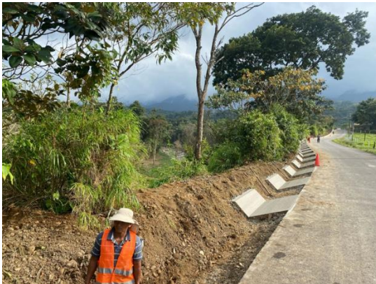
Cunetas para canalización de agua camino 2-10-135 Fuente: Comisión Municipal de Emergencias
