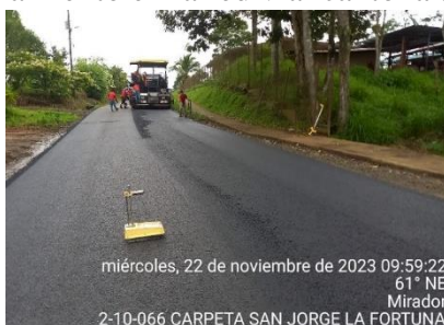
Carpeta Asfáltica, San Jorge, Fortuna
