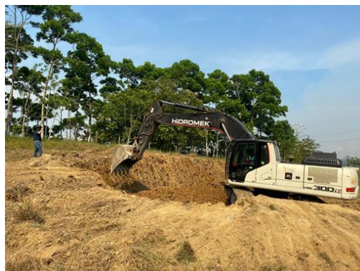
Extracción de material en Tajo Tiricias
