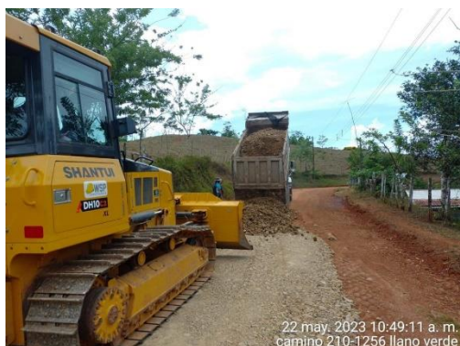
Colocación de material en camino 2-10-1256
