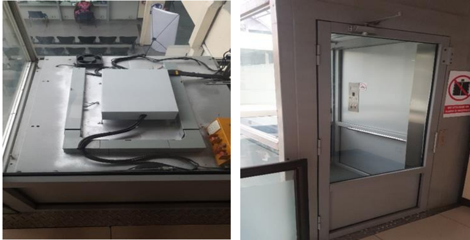
Mejoras a la Ley 7600 en Palacio Municipal Fuente: Municipalidad de San Carlos
