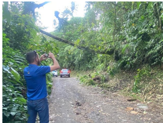
Daños en ruta municipal 2-10-497 Fuente: Comisión Municipal de Emergencias
