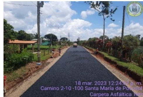
Carpeta Asfáltica, El Estrito, Pocosal
