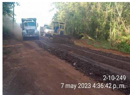
Colocación de material en camino 2-10-1256
