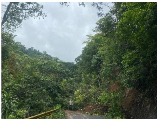
Deslizamiento ruta municipal 2-10-013 Fuente: Comisión Municipal de Emergencias
