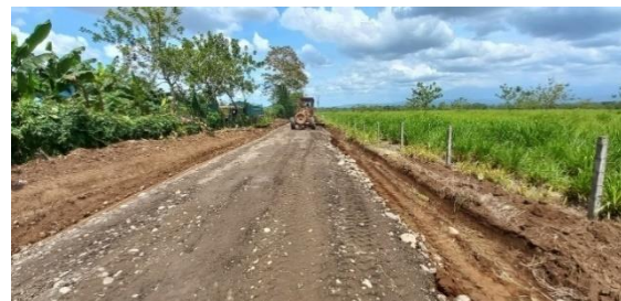
Evacuación Pluvial, Montelimar, Monterrey
