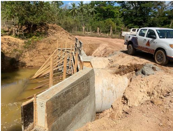
Colocación de material en camino 2-10-249
