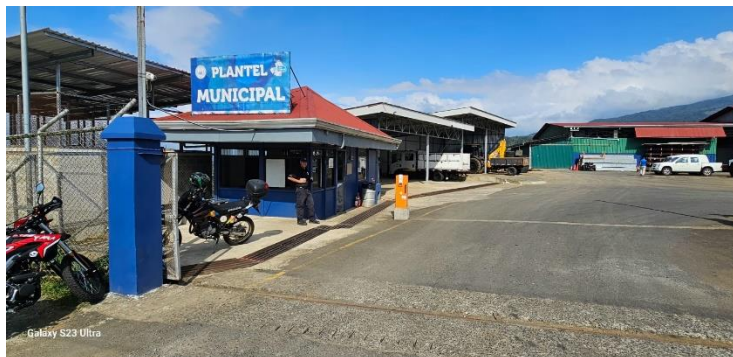
Revisión constante de las instalaciones municipales
