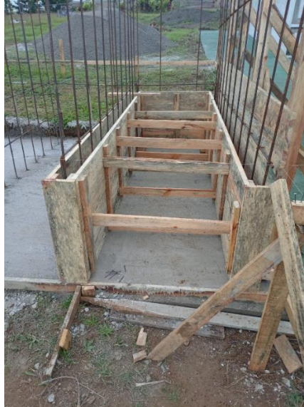
Construcción de nichos
