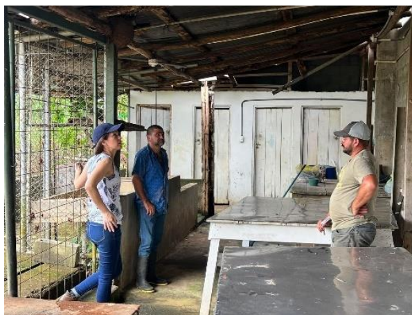
Levantamiento de estado de la estructura de la cocina, salón y espacio deportivo comunal
