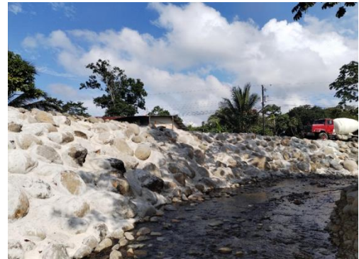
Protección a enrocado río Aguazarquitas Fuente: Comisión Municipal de Emergencias
