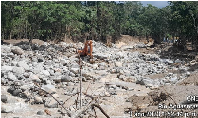
Limpieza de cauce sector detrás de caserío Calle Violeta Fuente: Comisión Municipal de Emergencias
