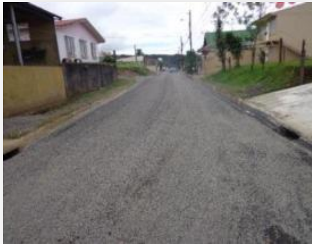
Tratamiento Superf. Bituminoso TE-50 en Asfalto: Los Maderos, Ciudad Quesada. 2-10-153
