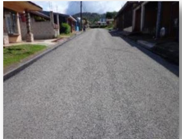
Tratamiento Superf. Bituminoso TE-50 en Asfalto: Los Maderos, Ciudad Quesada. 2-10-153
