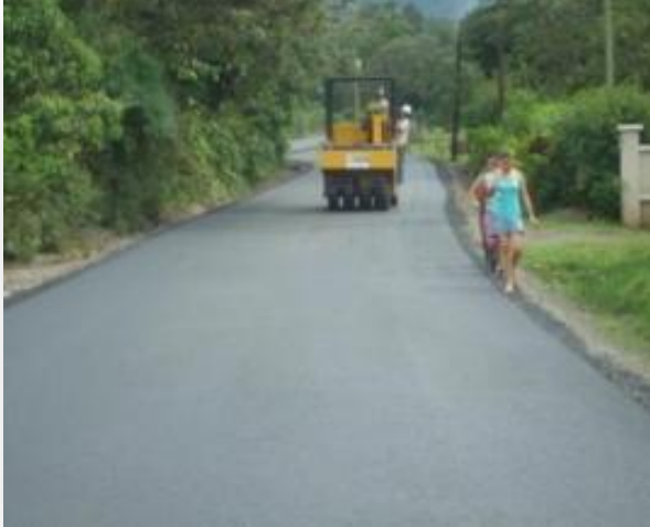
Carpeta Asfáltica, Santa Rita de Florencia:
