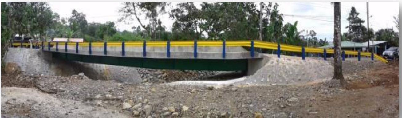
Vista Global del puente, escolleras, aproximaciones y barandas.
