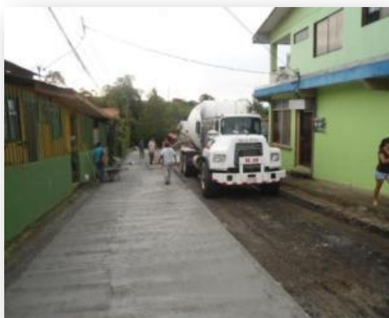
Carpeta Asfáltica, Calle El Milagro, Ciudad Quesada, 2-10-153
