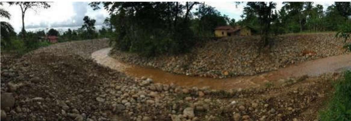
Rehabilitación paso en el sector de Vasconia, mediante construcción de puente vigas de madera y apilamiento de material granular para traslado camino 2-10-346.
