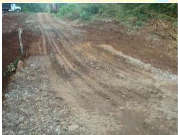
Dragado del río Aguas Zarcas y conformación de dique, apilamiento de material en ambos márgenes, Aguas Zarcas.
