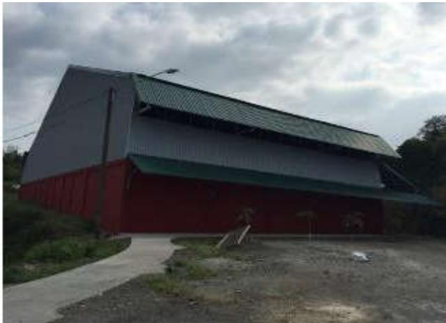
Cambio total de cubiertas de techo, aleros, tapicheles (1190 m<sup>2</sup>), pintura general del edificio (2050 m<sup>2</sup>)
