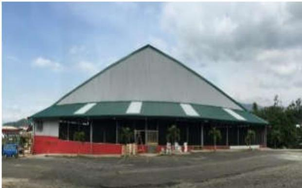
Cambio total de cubiertas de techo principal, aleros (1470 m<sup>2</sup>), pintura general del edificio (2050 m<sup>2</sup>), cambio malla y portón frontal
