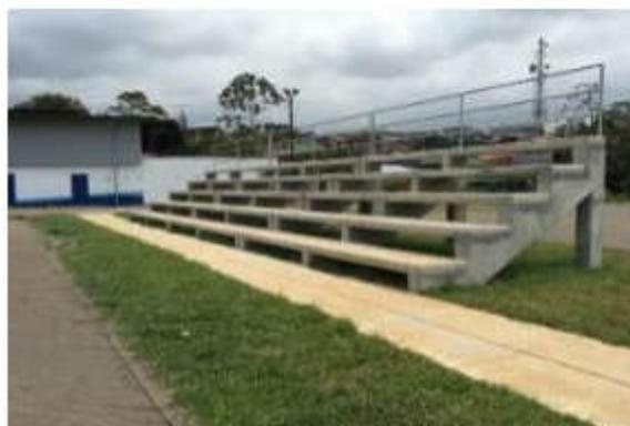
Construcción de gradería de concreto reforzado (216m<sup>2</sup>) y barandas
