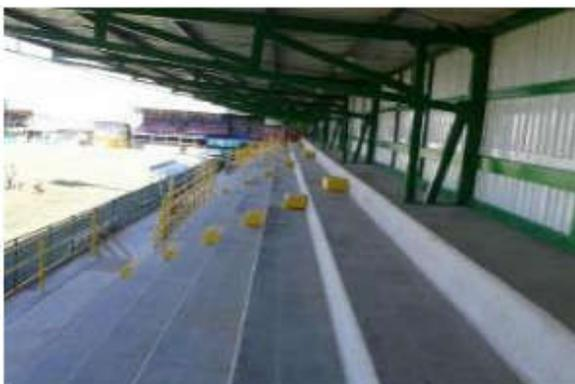
Demolición, construcción de nueva gradería prefabricada de concreto reforzado y estructura de techo (más de 420 m<sup>2</sup>)
