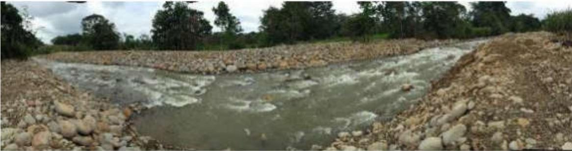
Conformación de material sobre tamaño en el inicio del dique hasta lograr con apilamiento sesgado con relación a la dirección del caudal sin implicar un cambio u obstáculo al flujo de agua. Apilamientos y conformaciones de material en ambas márgenes, para evitar el desbordamiento hacia sector vivienda y camino 2-10-635
